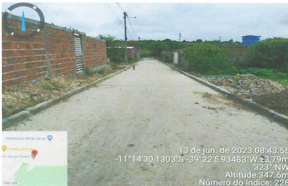
Execução de pavimentação e meio-fio/Rua projetada 15
