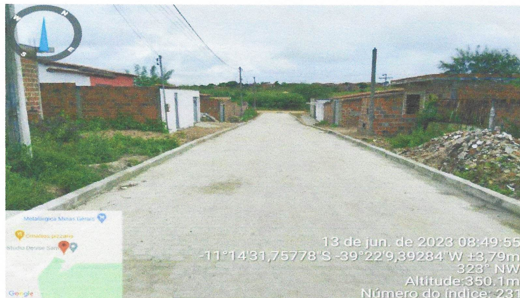
Execução de Pavimentação e meio-fio/Rua projetada 13
