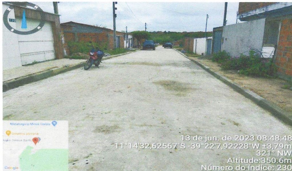
Execução de Pavimentação e meio-fio/Rua projetada 13
