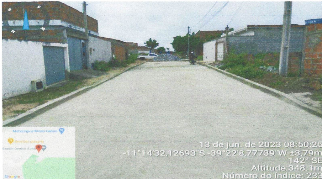
Execução de Pavimentação e meio-fio/Rua projetada 13
