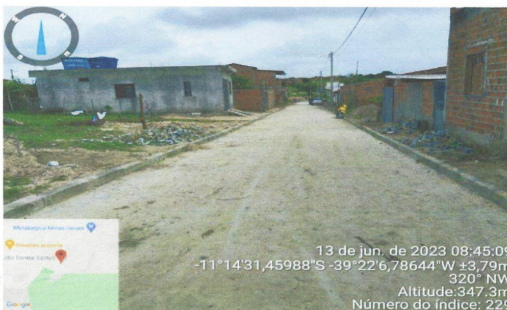
Execução de pavimentação e meio-fio/Rua projetada 14
